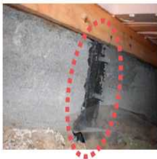
エポキシ樹脂による補修
