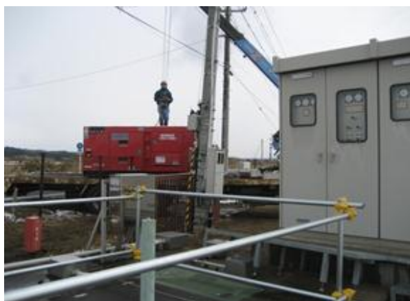
金成第1ポンプ場発動発電機設置状況
