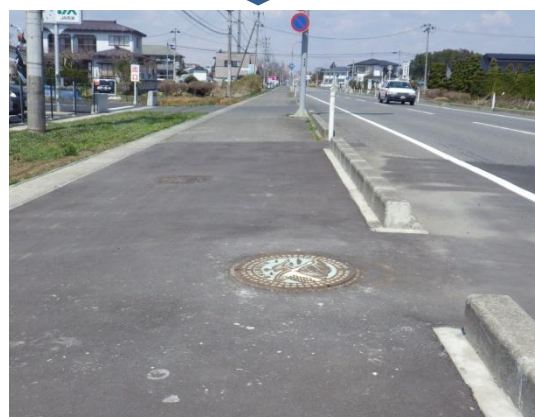
迫川右岸幹線マンホール完成 (H25年3月)
