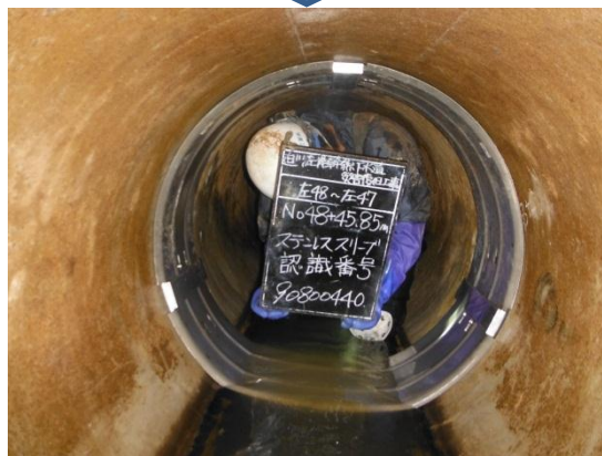
迫川左岸幹線管渠完成 (H25年3月)
