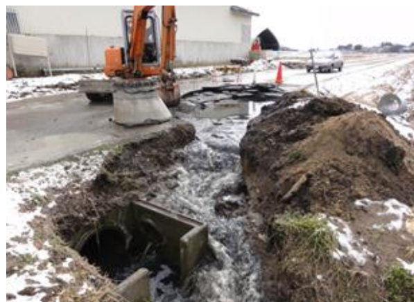
志波姫ポンプ場上流人孔の溢水対応状況
