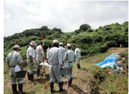
決壊した朴ノ木ため池（川崎町）における災害査定の状況
