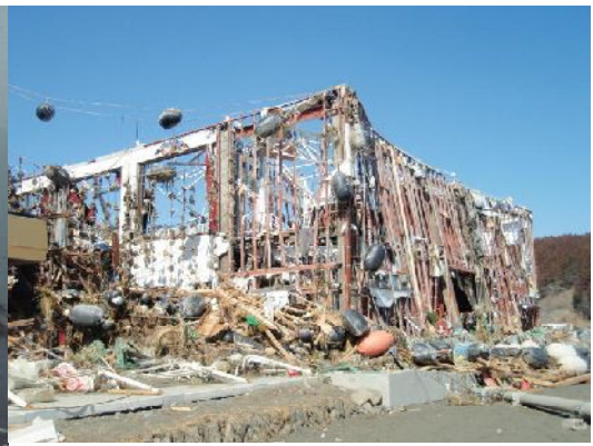
10日前に完成引き渡された体育館
