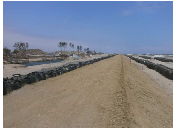
仮堤防盛土状況
