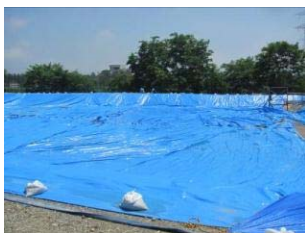
【シート覆工状況】
