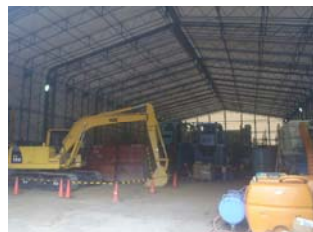
【テント内部 脱水作業】
