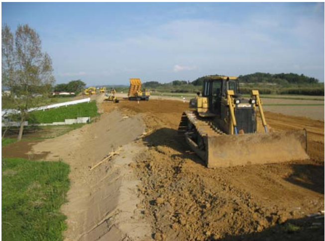
ゆるんだ土を取り除いた後、締め固めながら、もとどおりに土を盛ります
