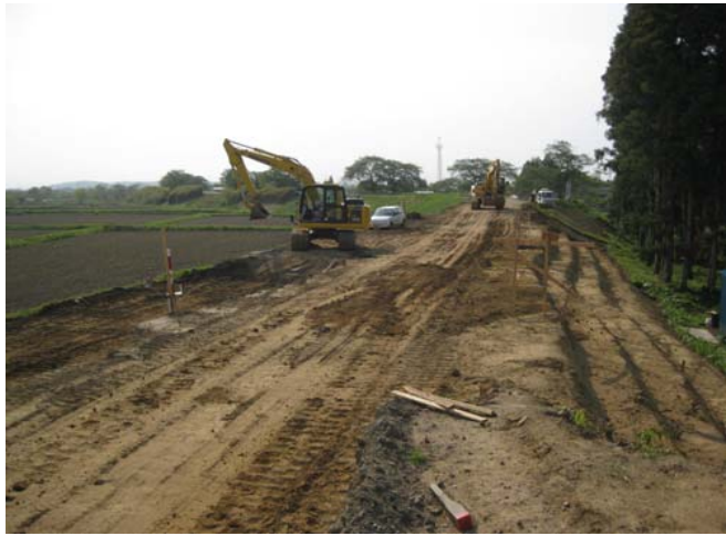
クラック調査の結果を基に、地盤のゆるんだ範囲の堤防の土を取り除きます
