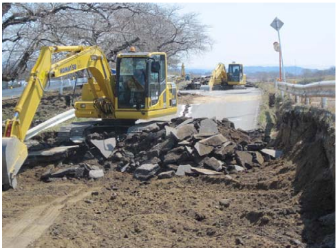
舗装を取り壊します
