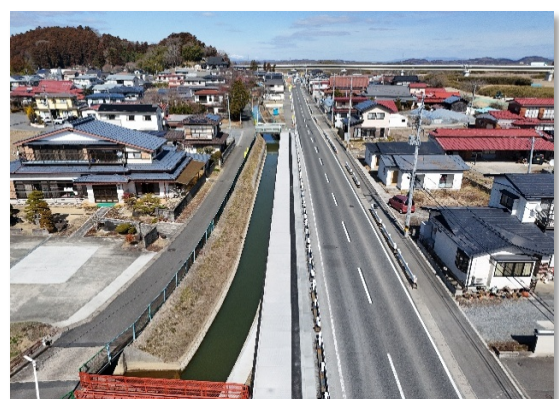
【工事の進捗状況(令和8年3月時点)】
