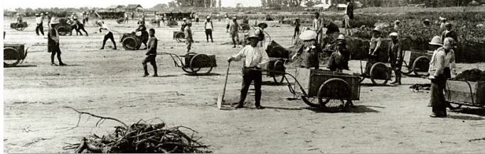
迫川改修工事の様子 (昭和10年代)
