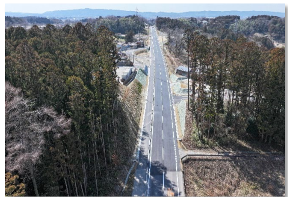
【工事の進捗状況(令和8年3月時点)】
