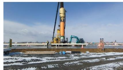
写真-2 深層混合処理の施工状況
