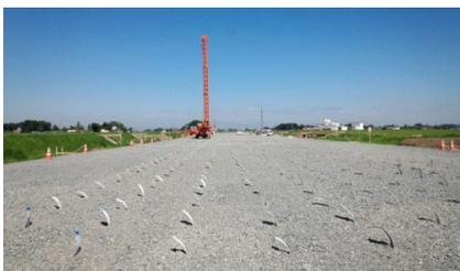
写真-1 プラスチックボードドレーンの施工状況
