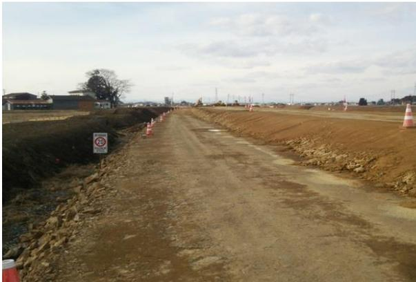
Ⅱ期（中田工区）4.7km区間については、平成26年度から用地買収に着手し、一部の多数相続発生地を除き用地取得済みで、平成27年度当初から終点側より地盤改良や盛土等の本格的な工事に着手し、現在は全区間について工事を実施しています。また、全体盛土量53万m<sup>3</sup>の内約25万m<sup>3</sup>を他工事から流用し、資源の有効活用及びコスト縮減を図っています。
