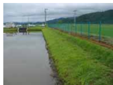
河南3期地区の調整池
