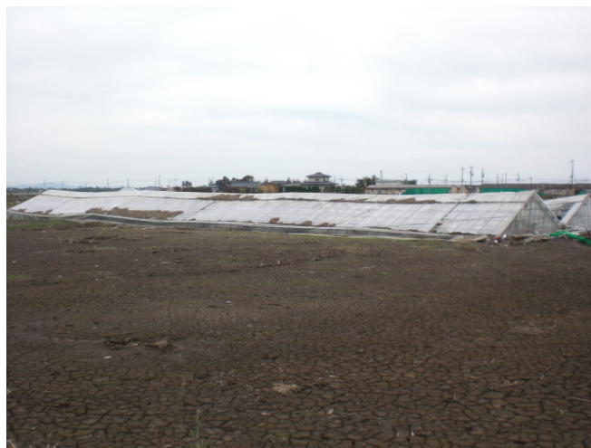
▲鉄骨ハウス倒壊
