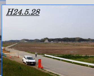
▲農地復旧工事後の様子
