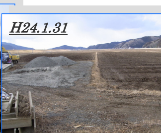
▲農地復旧工事の様子
