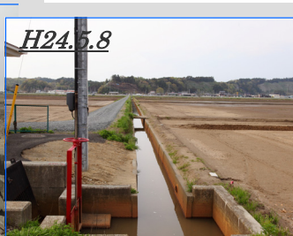
▲農地復旧工事後の様子
