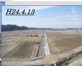
▲農地復旧工事後の様子
