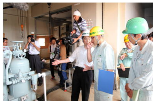
▲長面排水機場内の説明の様子
