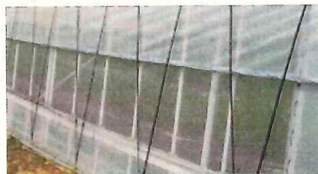
防虫ネットの設置
