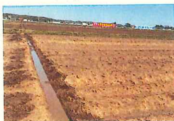
二重明渠の施工
