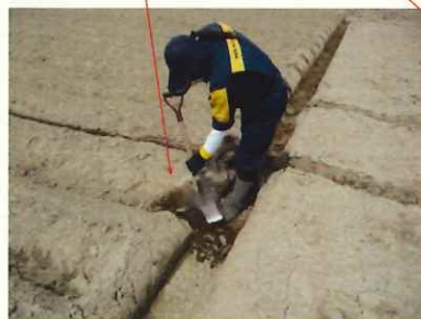
(有)サンダーファーム牛田の二重明渠へつなぐ作業
