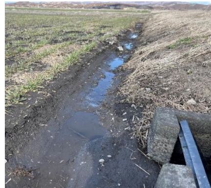
図4 停滞水が溜まる明渠 (落水口前に土が盛り上がっている)
