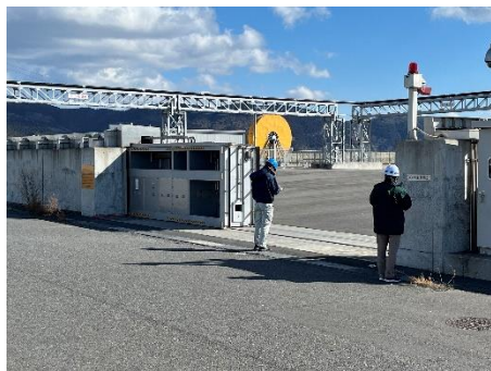
石巻漁港での陸閘点検状況
