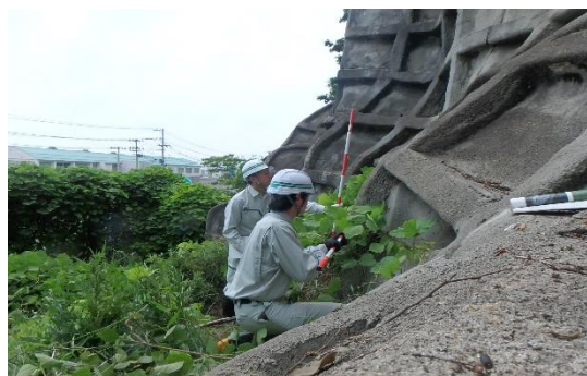
法枠の点検状況
