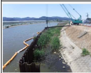
鋼矢板の仮締切を進めています。
