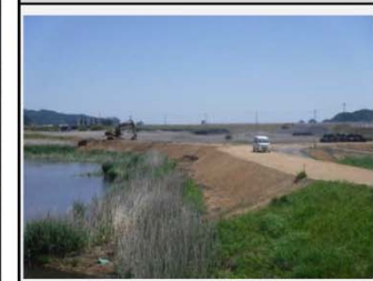
背割堤の盛土を進めています。
