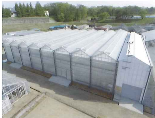
最先端の試験研究施設 軒高6m, 最新の環境制御機器を備えた施設
