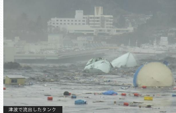
津波で流出したタンク
