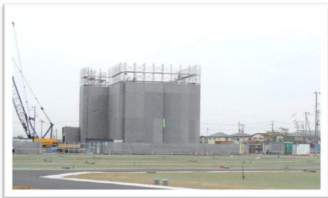
▲現在建築中の共同住宅タイプの災害公営住宅
