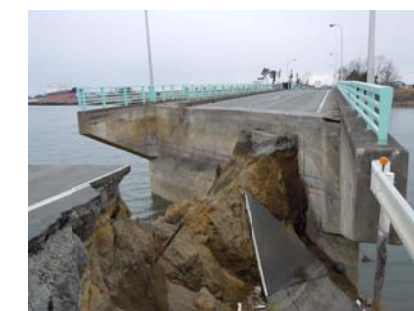
<橋台背面盛土の流失>
