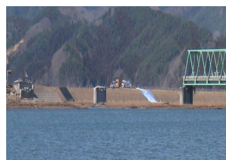
<上部構造の流失（津波波力）>
