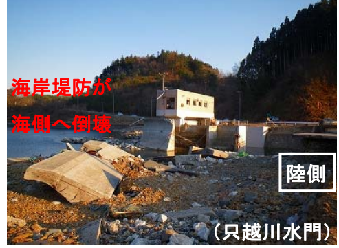
⑫- (4) 防潮水門に隣接する海岸堤防の被災
