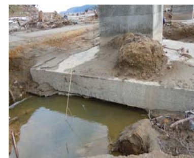
<基礎構造の洗掘>
