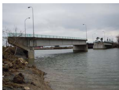
<上部構造の流失（船舶衝突）>
