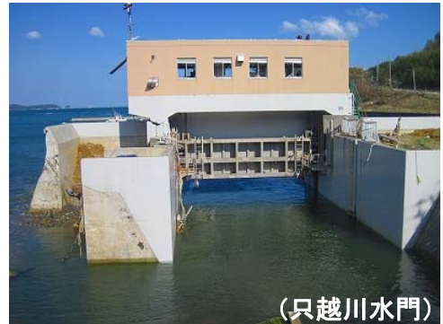
⑫- (4) 防潮水門に隣接する海岸堤防の被災
