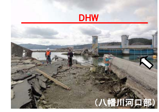
⑫- (2) 防潮水門に隣接する海岸堤防の被災
