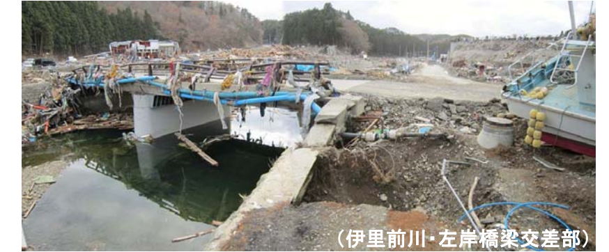
⑧ 隅角部への戻り流れ集中 (橋台背面)
