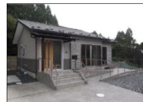
災害公営住宅整備状況 （石巻市大須地区）
