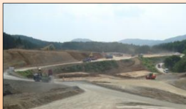
戸倉地区造成工事状況(南三陸町)
