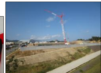
建設地造成状況 (南三陸町 志津川東地区)
