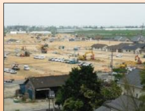
新山下駅周辺地区造成状況(山元町)
