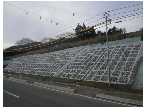
(主) 河南築館線 (涌谷町)
