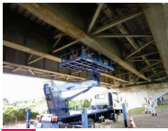
33 橋梁点検現地研修会
