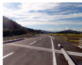
37 国道 398 号宮前工区開通
