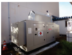
46 自家発電設備・無停電 電源装置
