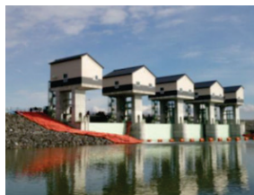
44 長沼ダムの試験湛水
