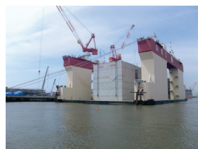
9 女川湾防波堤災害復旧工事ケーソン据付開始
