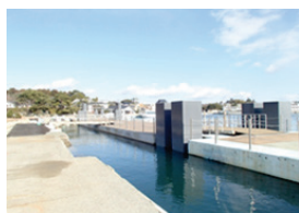
44 仙台塩釜港（松島港区） 浮さん橋
