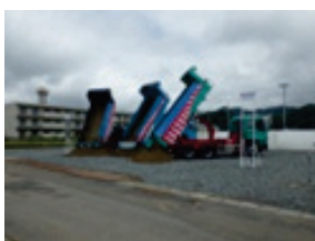
21 鹿折地区・南気仙沼地区復興 土地区画整理事業着工式
