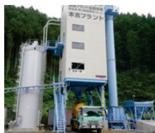
19 生コン仮設プラント (気仙沼市本吉地区)
