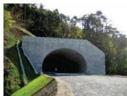
39 二ノ浜 1 号トンネル
