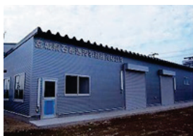
38 石巻港区大手ふ頭資材倉庫
