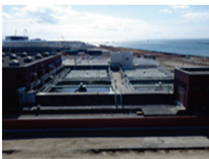
72 石巻東部浄化センターの水処理施設
