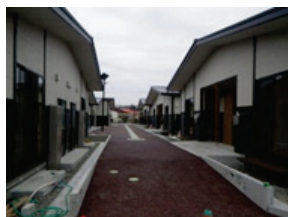
57 松島町磯崎華園地区災害公営住宅
