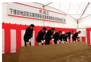
39 下増田地区防災集団移転促進事業 起工
