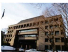
57 県庁舎・議会庁舎災害復旧完了
