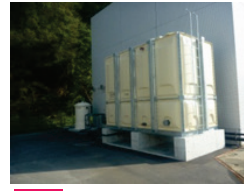
34 水産技術総合センター海水ろ過設備
