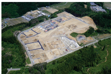
写真 4-2-21：防災集団移転団地の例
