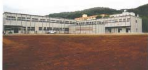
宮城県農業高等学校仮設校舎
