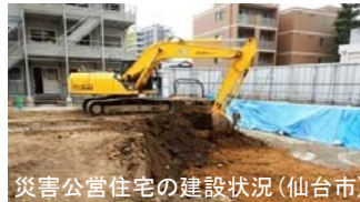
災害公営住宅の建設状況(仙台市)
