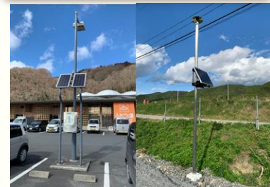
駐車場用街路灯
