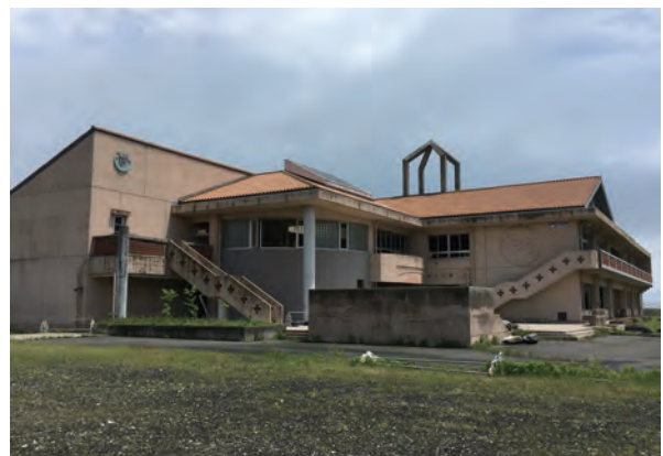
写真9-4 旧山元町立中浜小学校
