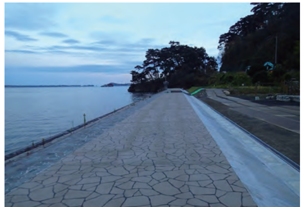
写真9-8 松島町浪打浜防潮堤の景観配慮
