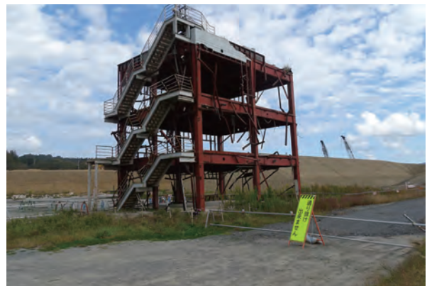
写真9-3 南三陸町旧防災対策庁舎
