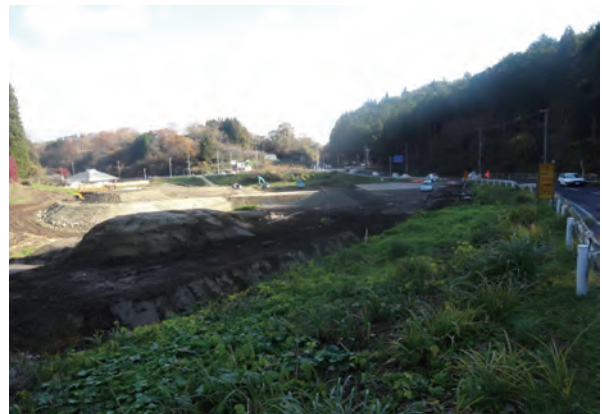
写真9-5 松島町石田沢避難所造成工事
