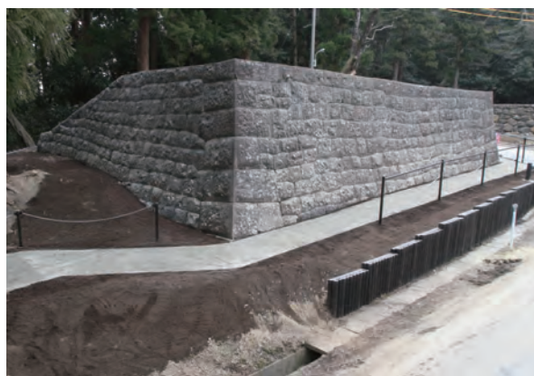
写真9-1 仙台城跡中門石垣復旧状況
