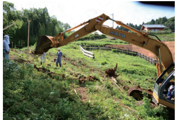
写真9-12 南三陸町県道改良工事試掘・確認調査
