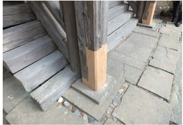
写真9-2 涌谷町旧妙見宮修復状況
