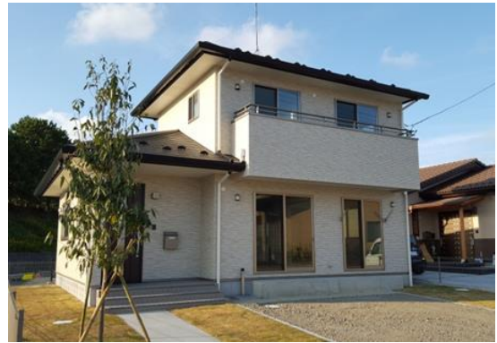
建物全景（七郷地区）
