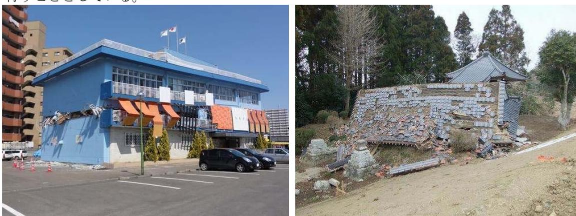
被災状況（左：鉄筋コンクリート造建築物2階部分の圧壊 右：木造建築物の倒壊）
