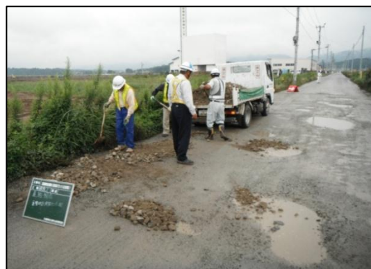
写真9-10 道路補修状況
