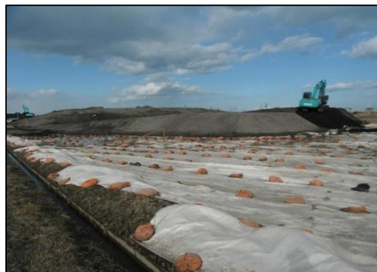
写真9-21 福島県の土砂仮置き場
