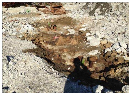
写真9-37 油混じり土砂の保管状況
