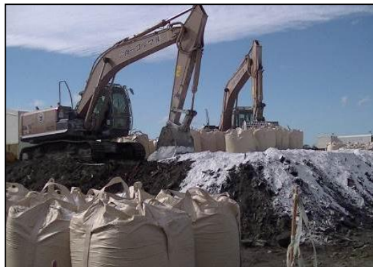
写真9-28 津波堆積物の改質状況
