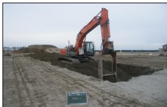
写真9-8 地盤改良状況
