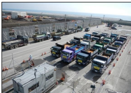
写真9-12 車両待機スペース
