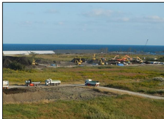
写真9-25 二次仮置き場外での処理
