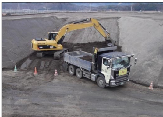
写真9-20 再生土砂の積み込み
