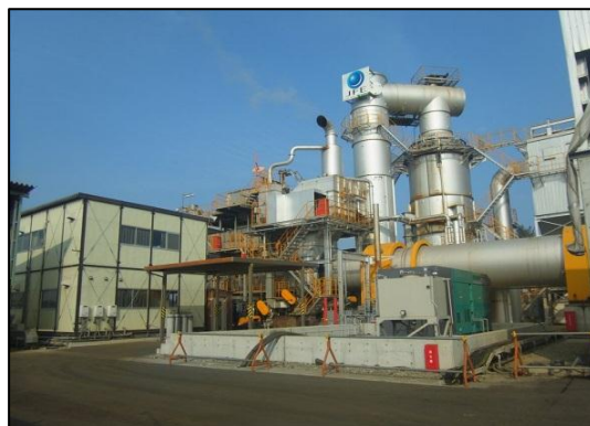
写真10-12 仙台市の仮設焼却炉（蒲生搬入場）
