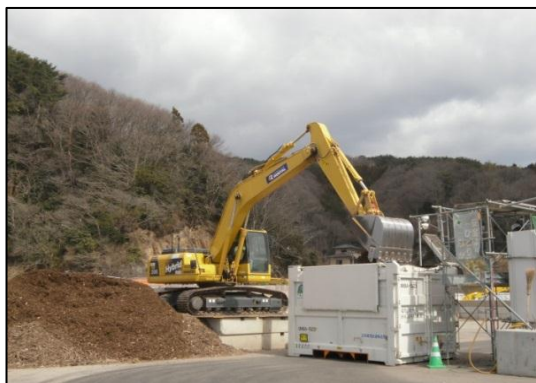
写真10-6 廃棄物の積み込み（女川町）
