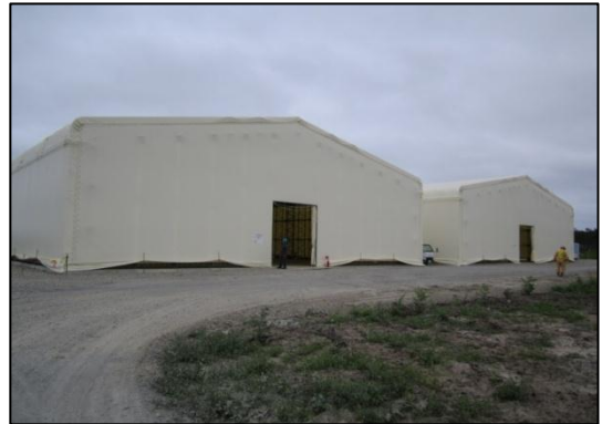
写真8-39 飛灰保管テント
