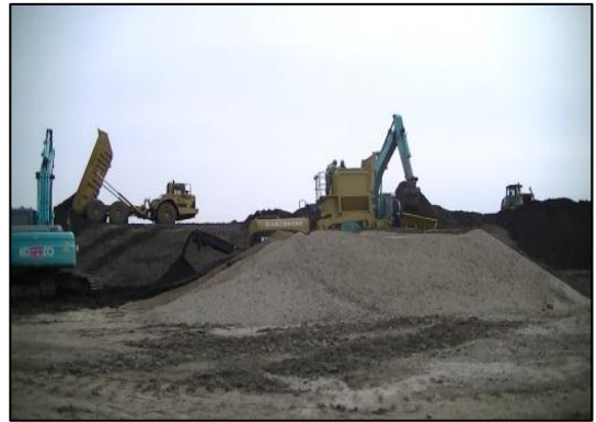
写真8-38 津波堆積物の改質・処理状況
