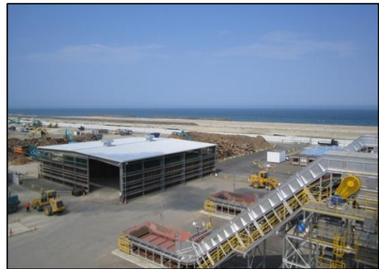
写真8-5 可燃物集約施設
