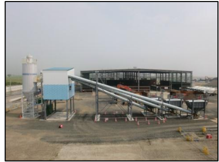
写真8-32 練混ぜ施設 (バッチャープラント)
