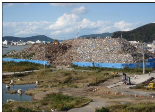
写真4-4 川口町1次仮置き場
