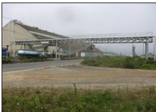
写真4-38 日本製紙(株)所有排水管橋
