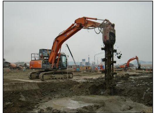
写真4-14 地盤改良状況
