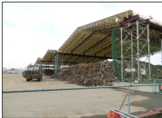
写真4-33 可燃物保管テント
