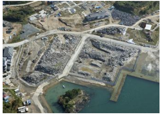
写真4-6 表浜港湾用地一次仮置き場
