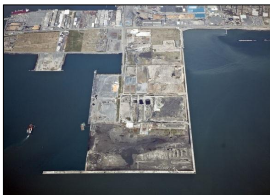
写真4-11 造成着手前(平成23年10月撮影)
