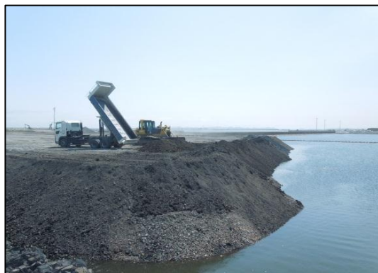
写真4-37 港湾埋立状況
