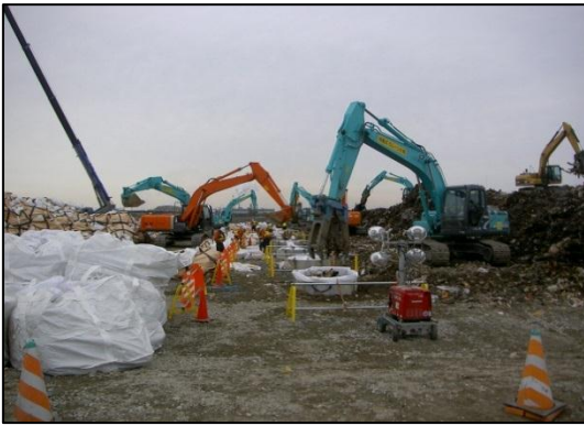
写真4-13 既存廃棄物撤去の状況
