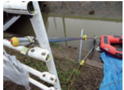
土手に手すりと階段を設置
