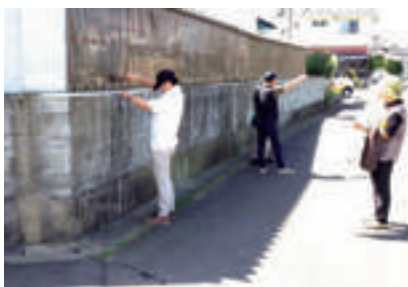
ブロック塀の確認
