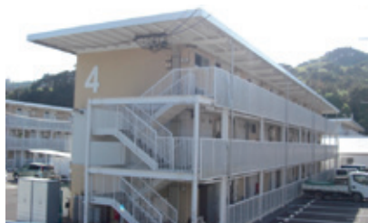
写真:仮設住宅(女川町)
