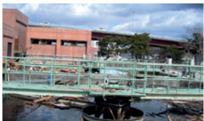
写真：石巻東部浄化センター(石巻市)
