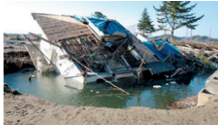
写真：津波被害を受けた松島 自然の家（東松島市）
