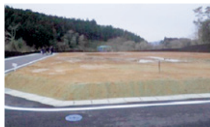
写真: 造成工事が完了した藤浜団地(南三陸町)
