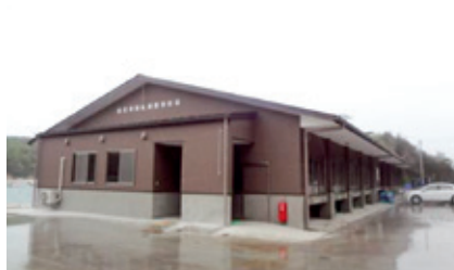
写真: 整備された水産加工施設(石巻市)
