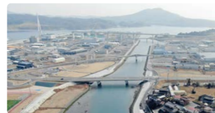
大川外河川災害復旧事業完了 (気仙沼市)
