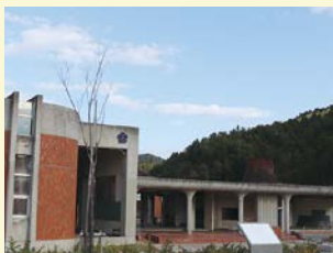
石巻市震災遺構大川小学校
