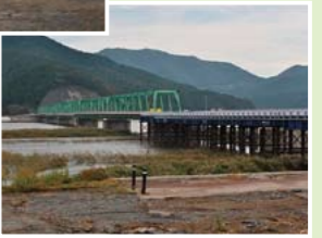
復旧状況（2011年10月）
