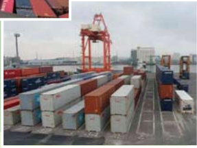
復旧状況（2011年7月）
