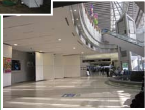
復旧状況（2012年1月）
