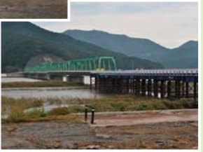
復旧状況（2011年10月）
