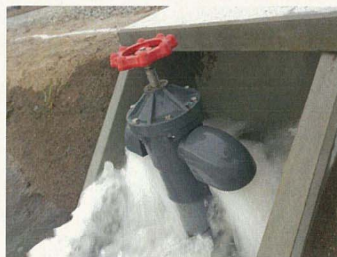
写真2 復旧・大区画化された水田への新設パイプラインによる除塩用水湛水作業
