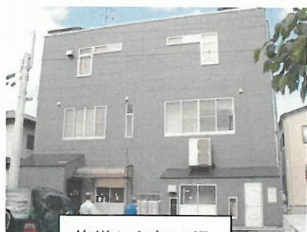
修繕した加工場
