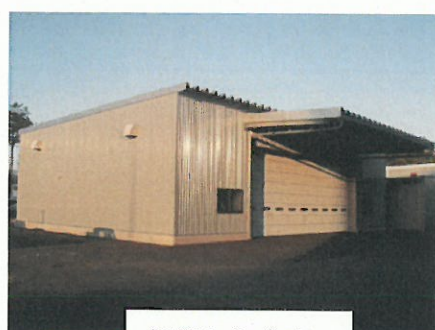
新築した倉庫
