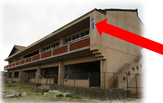
震災遺構・中浜小学校（山元町）
