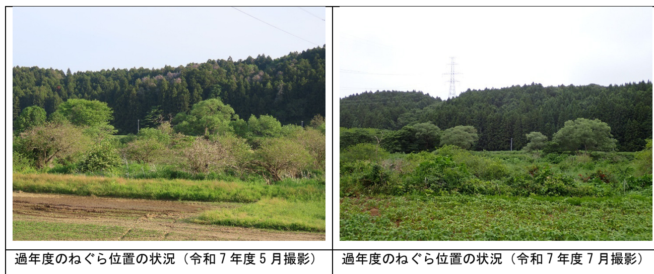
図 3-6 鳴瀬川 左岸 斉田の状況
