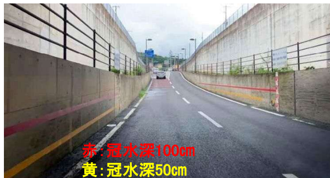
▲写真② 浸水深のライン
