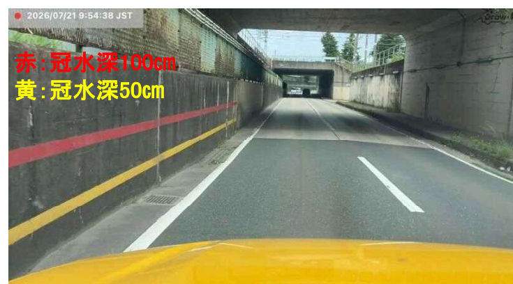
▲写真① 浸水深のライン
