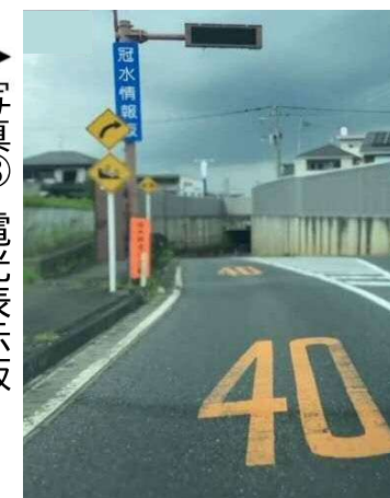
▶ 写真③ 電光表示板
