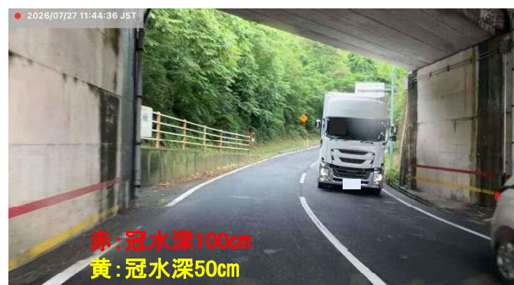
▲写真① 浸水深のライン
