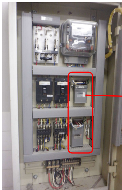
盤内 低圧進相コンデンサ (赤枠部)
