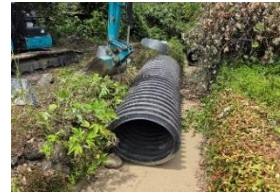
幹線用水路 応急工事状況 (氷川町)
