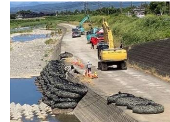
氷川（氷川町）応急工事
