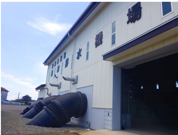
▲ 鶴家排水機場
