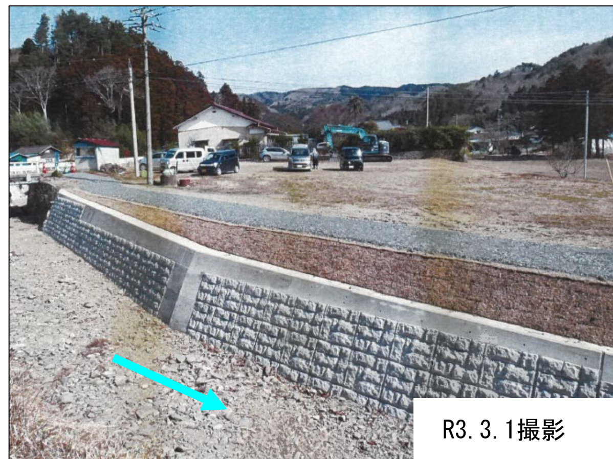
復旧完了（内の原川）
