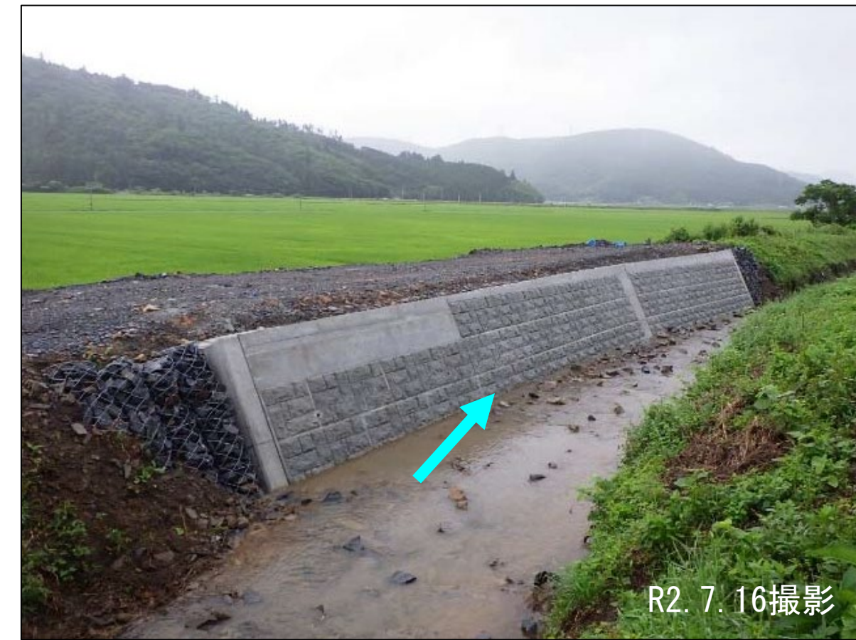
復旧完了（水沼川）
