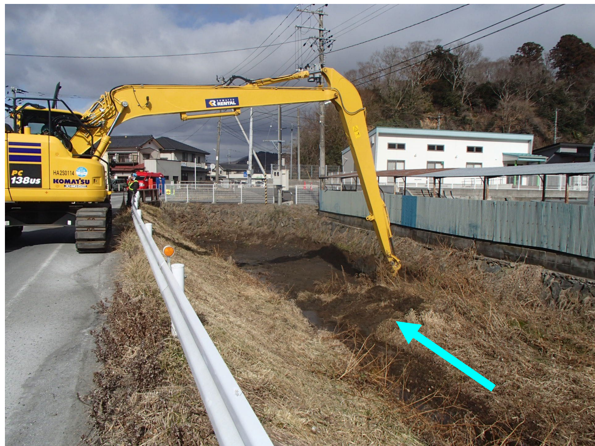
堆積土砂撤去（大森川）
