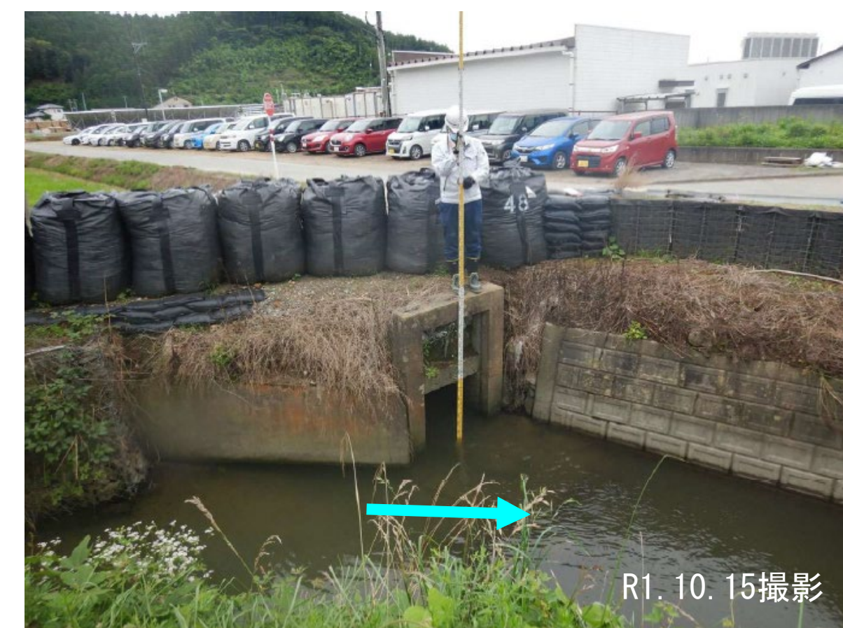
土のう設置状況（大森川）
