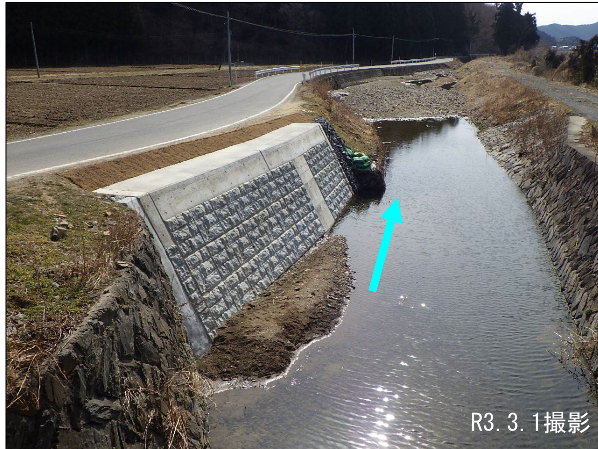
復旧完了（真野川）
